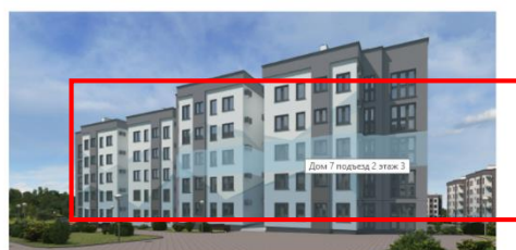
Этаж 3 Подъезд 2 Район застройки ул. Каштановая (очередь 2)
